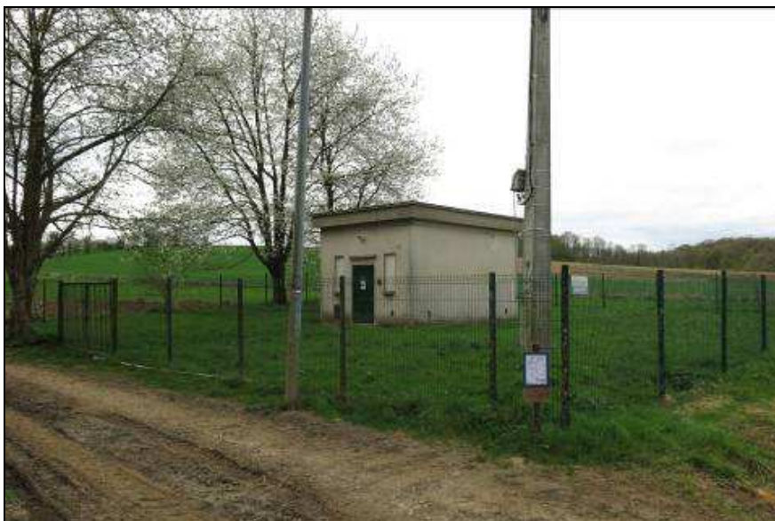
Station de pompage de Blainville Crevon (avril 2014 avant travaux de la bête de reprise)
