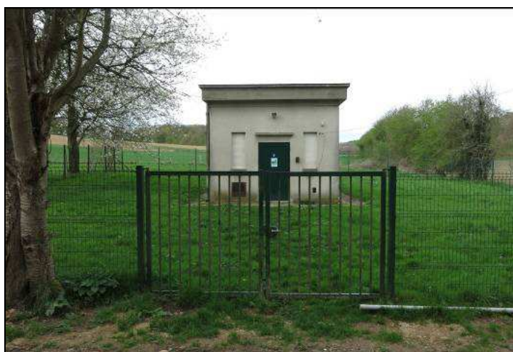
Vue sur le bâtiment technique abritant le forage (avril 2014 avant les travaux sur la bâche de reprise)
