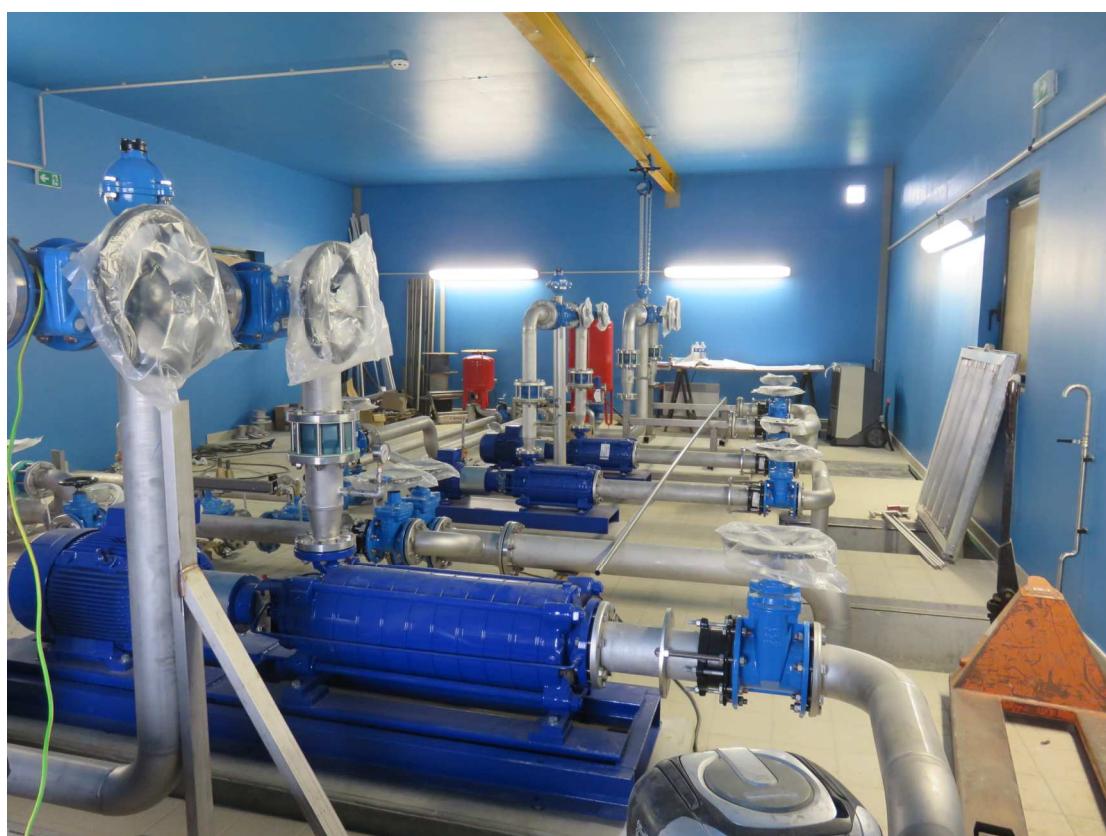
Salle de pompage créée
