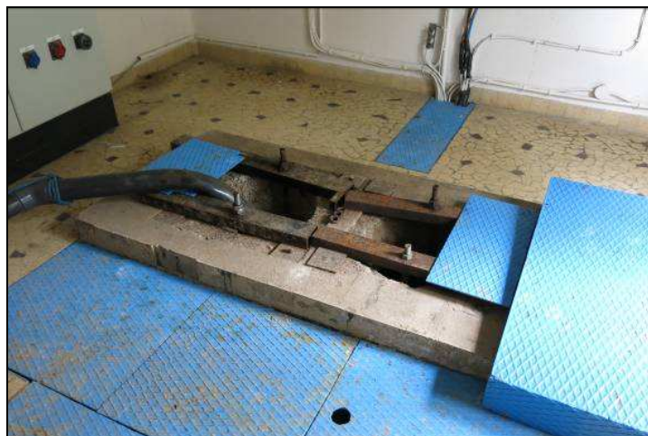
Ouverture du puits dans le bâtiment technique
