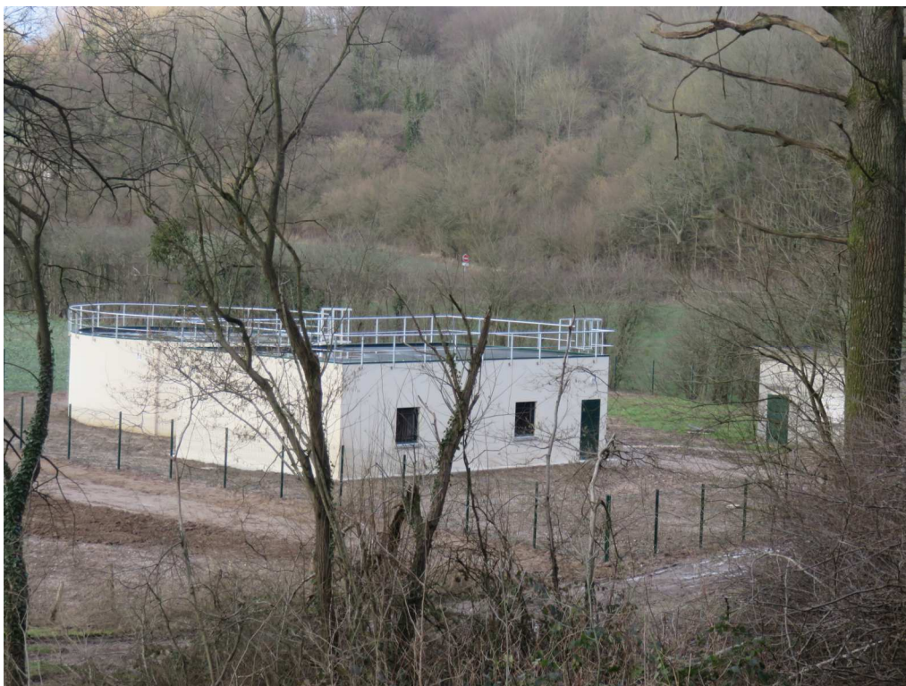
Bâche de dilution et station de pompage créées à côté du forage de Blainville Crevon (mise en service en décembre 2014)
